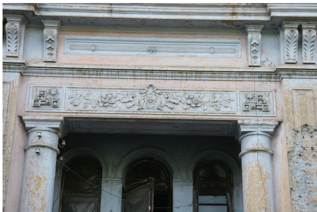
Рис. 7. Фрагмент главного фасада. Балкон
