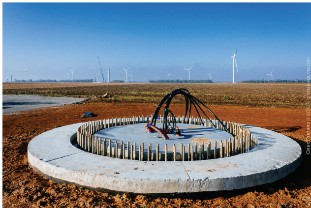
Фото 3. Фундамент ветрогенератора
