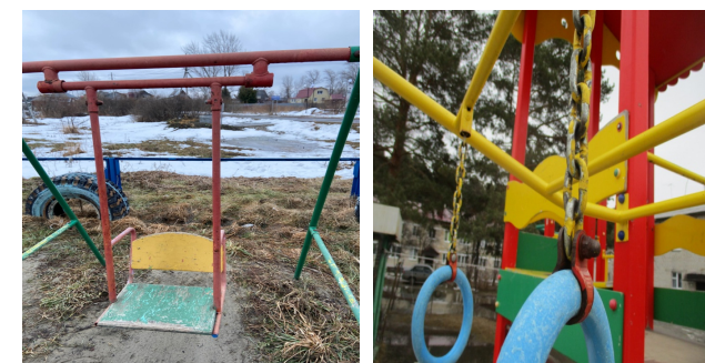
Рис. 5 – Дефекты металлических малых архитектурных форм
