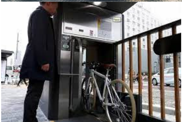
Рис. 7 Подземная велопарковка г. Эйндховен, Нидерланды, подземная велопарковка Токио, Япония
