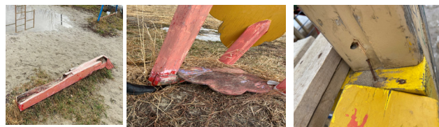
Рис. 4 – Дефекты деревянных малых архитектурных форм
