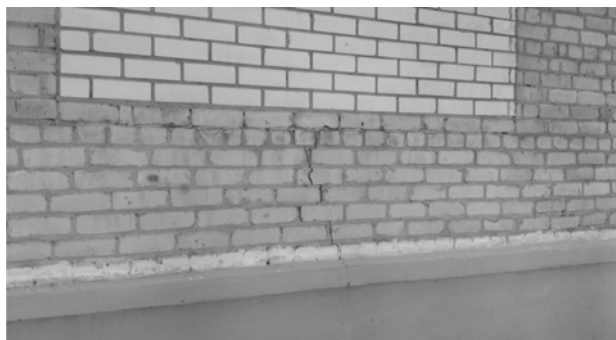
Фото 2. Разрушение нижней части стены в 5-этажном здании, г.Элиста
