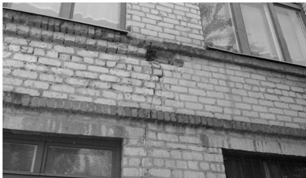
Фото 1. Разрушение верхней части стены в 5-этажном здании, г.Элиста
