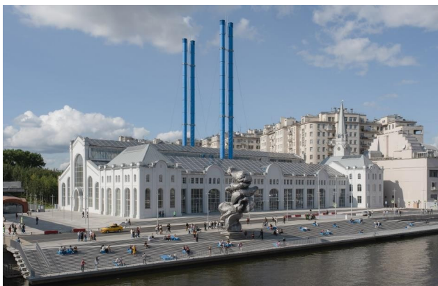
Рис. 2. Вид на ГЭС-2 со стороны набережной.
