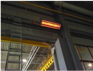
Рисунок 1 – Размещение ГИИ в промышленном цехе
